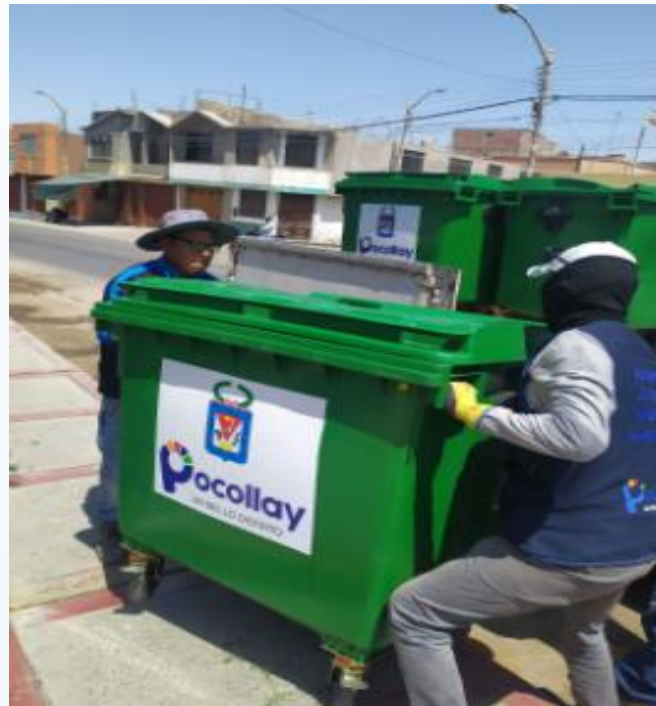
Instalación de nuevos contenedores de almacenamiento de residuos sólidos
